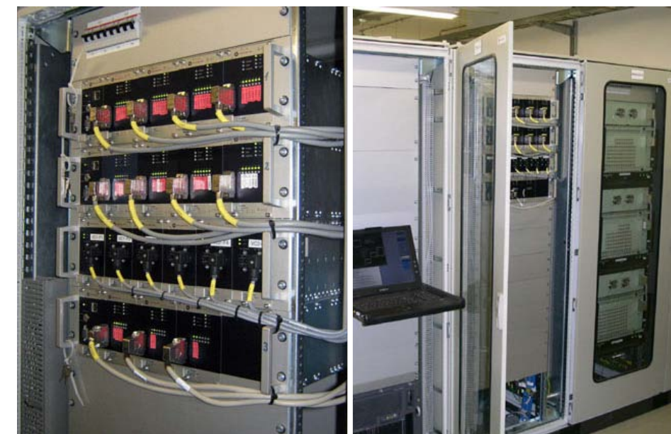
Serverschränke der Firma Borealis mit Compass 6000-System. Der Server, das VC-6000™-System und das COMPASS Classic-System sind in den ersten drei Schränken auf dem rechten Bild untergebracht. Das linke Bild zeigt eine Nahaufnahme des VC-6000™ (mittlerer Schrank).
