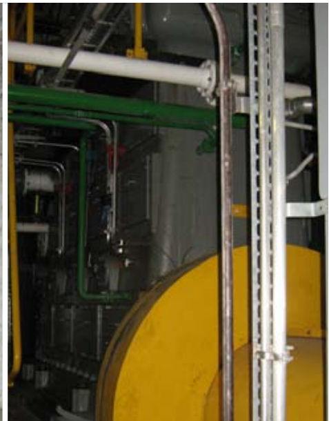
Ein Beschleunigungsmesser (links) ist auf dem Rahmen eines Ethylen-Kompressors (rechts) montiert
